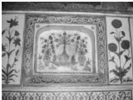
Attaque du marbre par les gaz issus des fonderies d'Agra.
